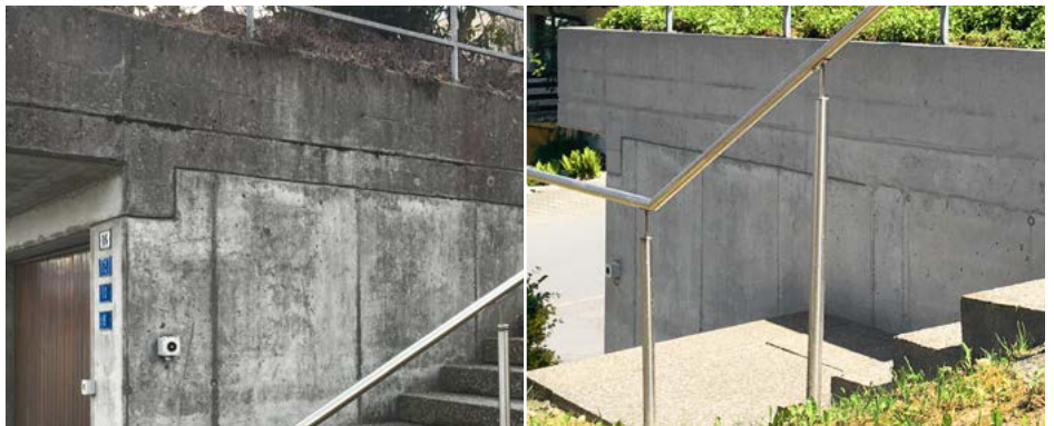
Verschluss der Bindlöcher, Oberflächenbehandlung mit Betonkosmetik, Renovation aller Flächen mit mineralischen Lasurfarben
