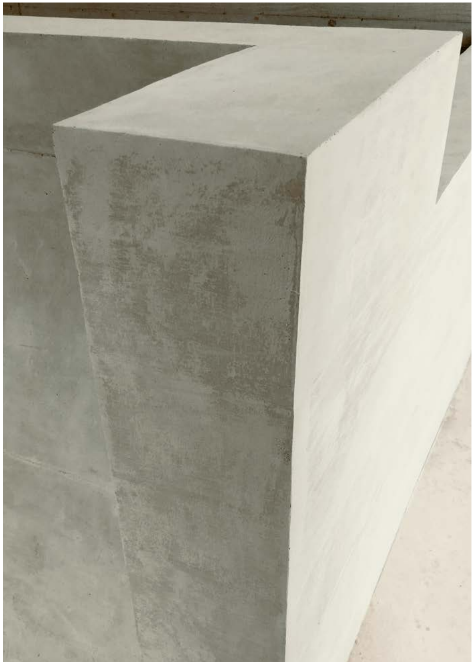
Bis zu 3cm Überspachtelung, Reprofilierungsarbeiten ohne Verwendung von Farben
