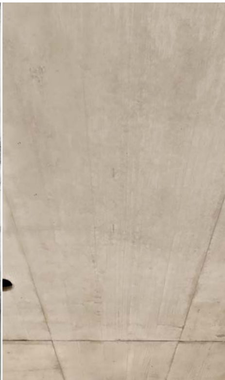
Vor und nach der Behandlung der Decke, Oberflächenbehandlung mit mineralischen Lasurfarben
