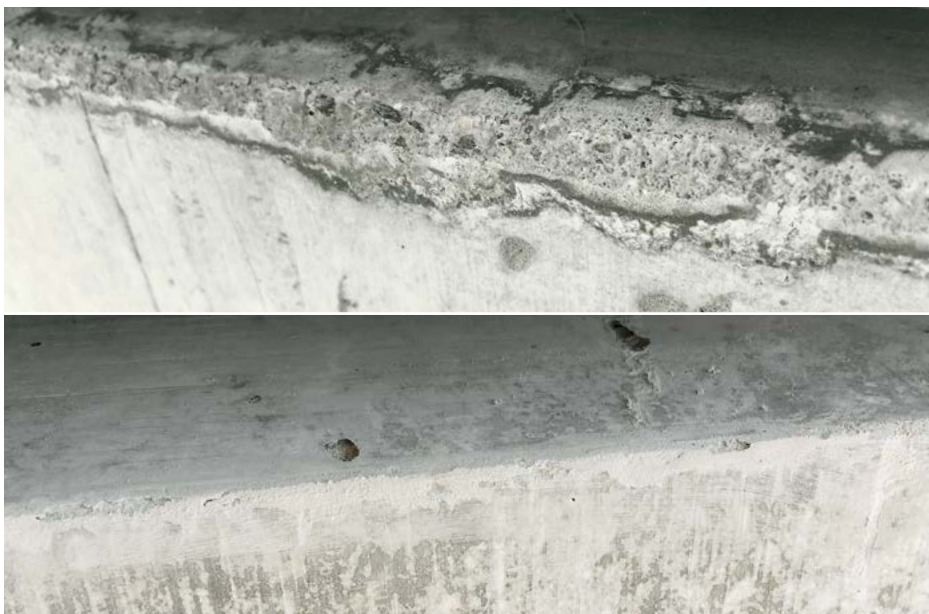
Reprofilierung von Kanten zur Überdeckung von bestehenden Kiesnestern
