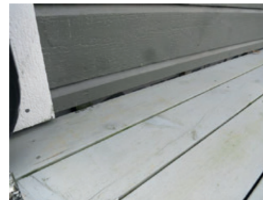
Åpent inn til vindtettingsduk.
