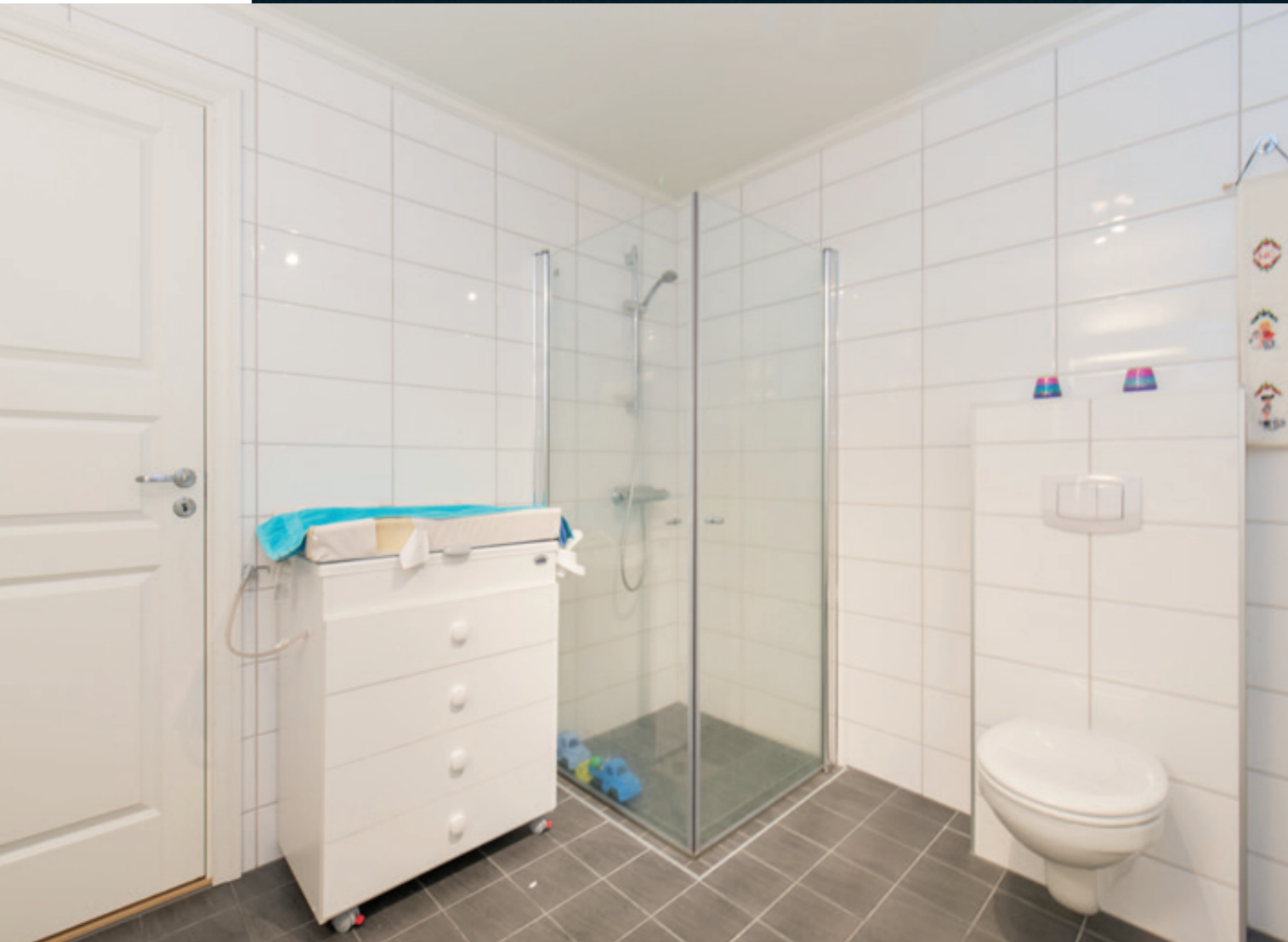
Helfliset bad ved varmekabler i gulv
