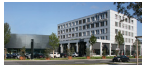
Office Zug: Alte Steinhäuserstr. 1 in Cham
