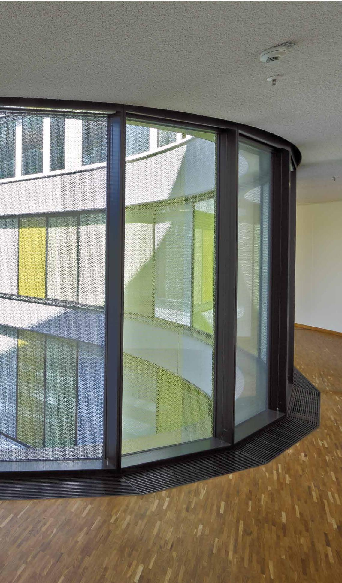
In der neuen ADAC-Zentrale in München sorgt eine Sonderlösung der Bodenkanalheizung Katherm HK mit energieeffizienten EC-Querstromventilatoren für eine laufruhige Betriebsweise und Energieeinsparungen. Diese Bodenkanalvariante führt bedarfsgerecht gefilterte, beheizte oder gekühlte Umluft aus dem Boden zu.
