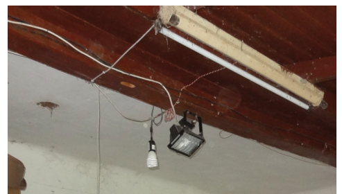
die elektrischen Installationen
