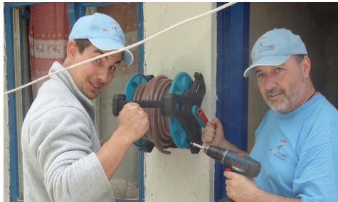
Die WIOCA Männer installierten mehrere Wasser-schläuche.
