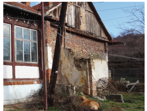
Die Aussenwände müssen repariert werden.
