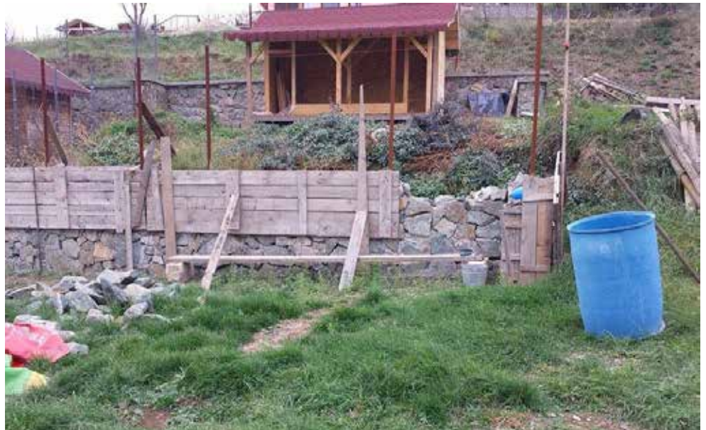
Dieses Gehege befindet sich derzeit im Bau und wird demnächst fertig gestellt.
