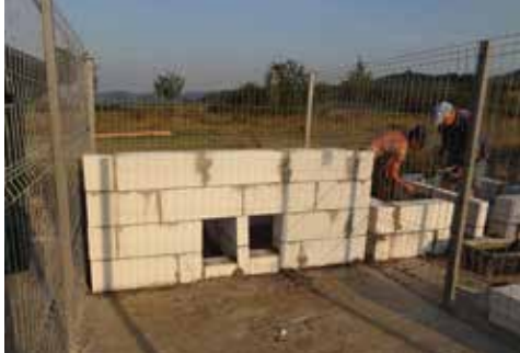
Hundehütten aus Porenbeton-Steinen
