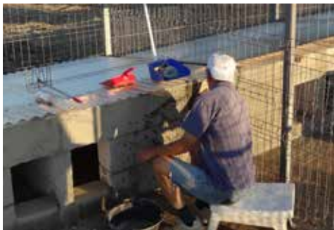
Isoliertes Dach mit wasserdichtem Wellkunststoff
