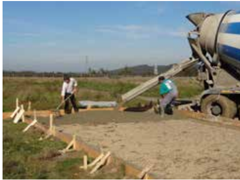
Fundament für das WIOCA Katzenhaus
