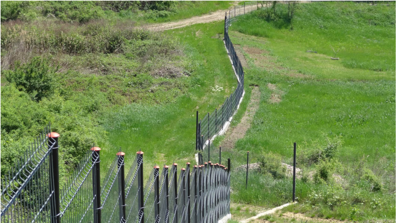
Dieser Teil des Zauns war im Mai 2012 bereits fertiggestellt.
