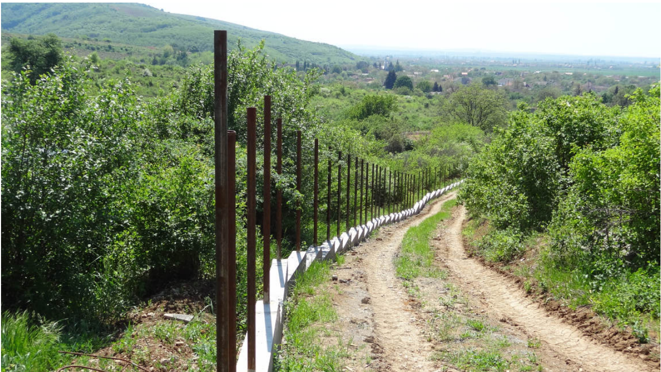
Dieser Abschnitt befand sich noch in Bau. Im Frühling 2013 soll der gesamte Zaun fertig sein.
