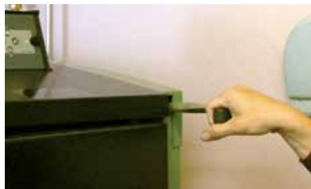
Die gesamte Bedienung – ob Einstellen, Befüllen, Betätigen der Entgasungsklappe und Abreinigung der stehenden Wärmetauscherflächen - alles ist von vorne möglich.
