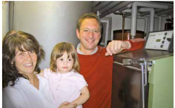
Familie Moser heizt mit einem HDG Navora mit 30 kW und 2.000 l Pufferspeicher.
