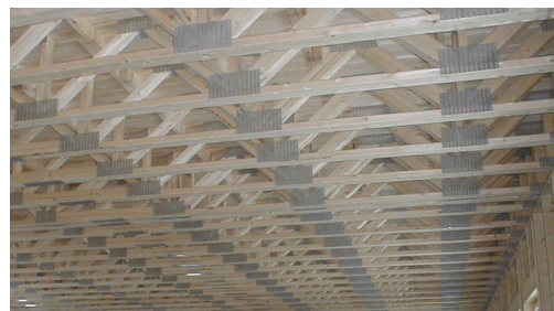
Gitterbjelkelag for montering av himling og overgolv
