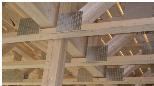
Gitterbjelkelag med integrert bærebjelke og søyle
