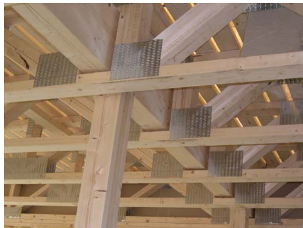
Figur 3. Gitterbjelkelag med integrert bærebjelke og søyle
