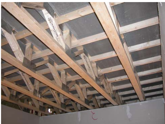
Figur 1. Bilde av et åpent gitterbjelkelag med tverrstiving.
